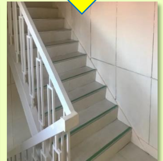
階段のタイル張替えと壁のペンキ塗り
