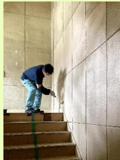
階段のタイル張替えと壁のペンキ塗り
