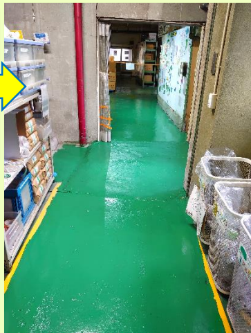
通路のデコボコ補修
