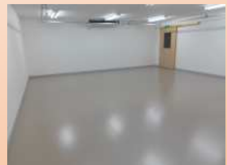
倉庫を検査室にリフォーム
