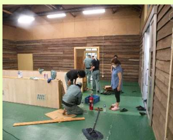
倉庫の床張り実施
